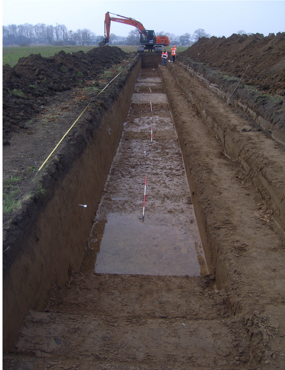
Afbeelding 5.13 Overzicht van werkput 8 (vlak 1) vanuit het oosten.
