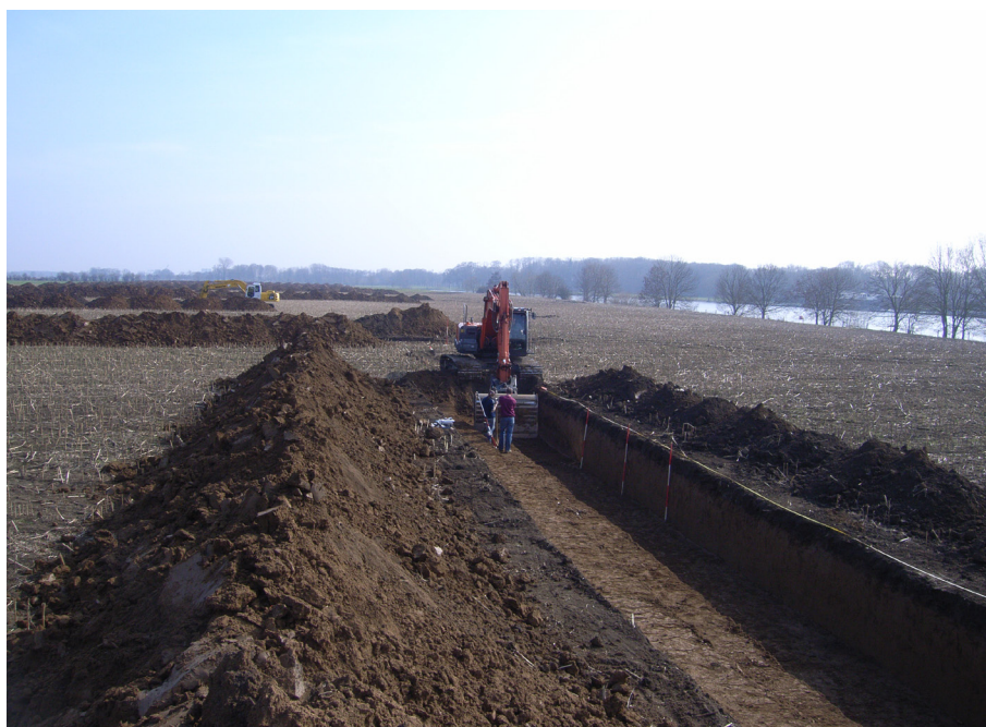
Afb. 6.1 Werkput 27 tijdens de aanleg met op de achtergrond, haaks erop, werkput 10 (foto genomen vanuit het noorden).
